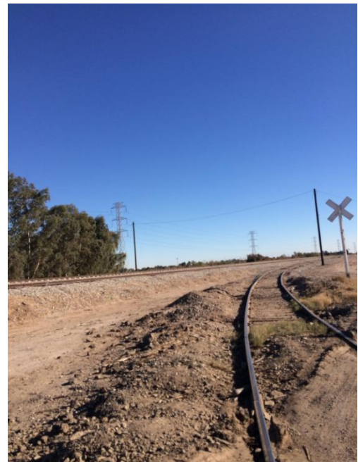
Línea de Ferrocarril Pacífico Norte
