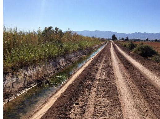
Canales del sistema riego.
