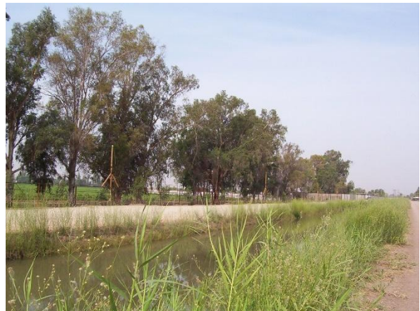
Infraestructura hidráulica (Canales)
