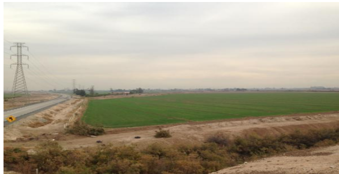
Líneas de alta tensión
