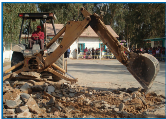
Construcción cancha de usos múltiples, Mexicali.
