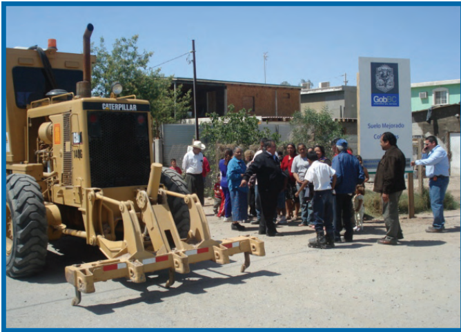
Arranque de suelo mejorado, Mexicali.
