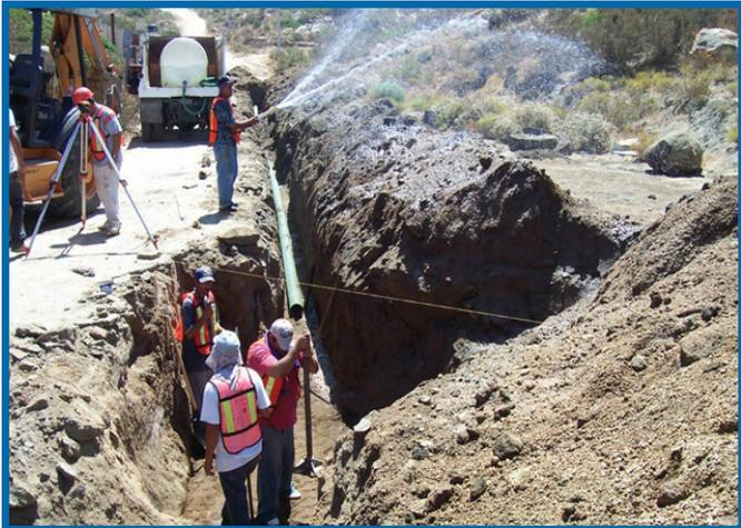
La obra constará de captación, planta desaladora con capacidad de 250 litros por segundo, 14.4 kilómetros de línea de conducción de 20 pulgadas de diámetro y 3.5 kilómetros de línea de alimentación a tanques del mismo diámetro. El 40% del monto de la obra será una aportación a fondo perdido por parte del Gobierno Federal a través del Fondo Nacional de Infraestructura (FONADIN). A la fecha, este proyecto se encuentra en proceso de licitación.
