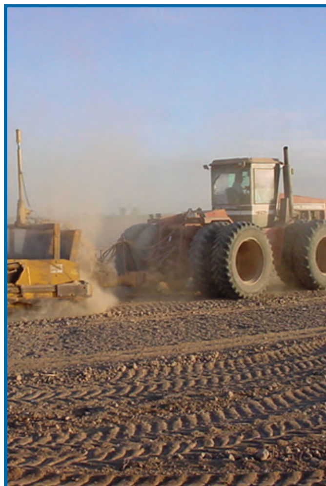
Nivelación de suelo, Valle de Mexicali.
