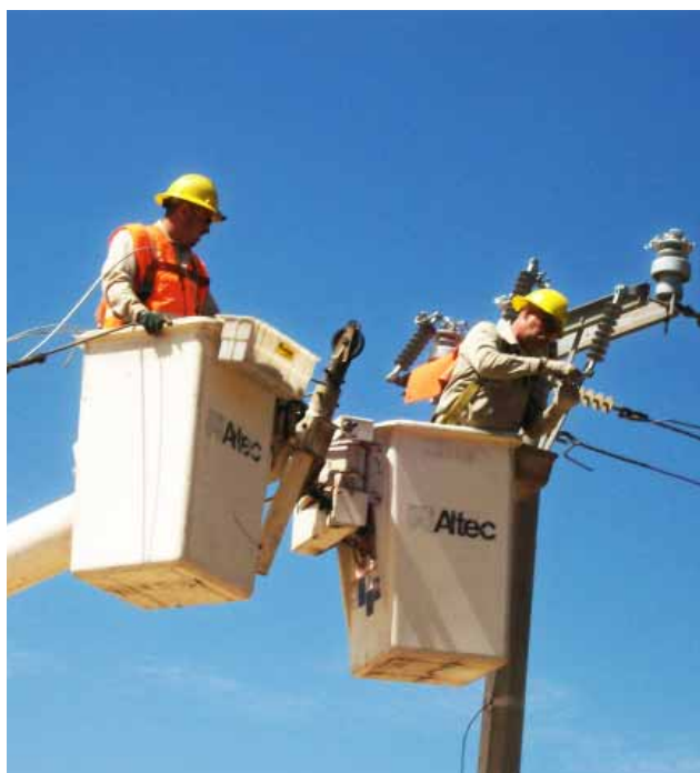
Ampliación de electrificación en el Estado
