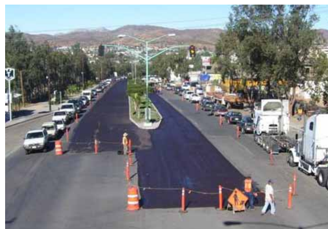
Pavimentación de vialidades en Tecate.
