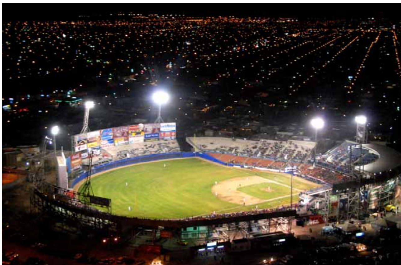
Acondicionamiento del Estadio de Beisbol "Casas Geo" en la Ciudad Deportiva de Mexicali.
