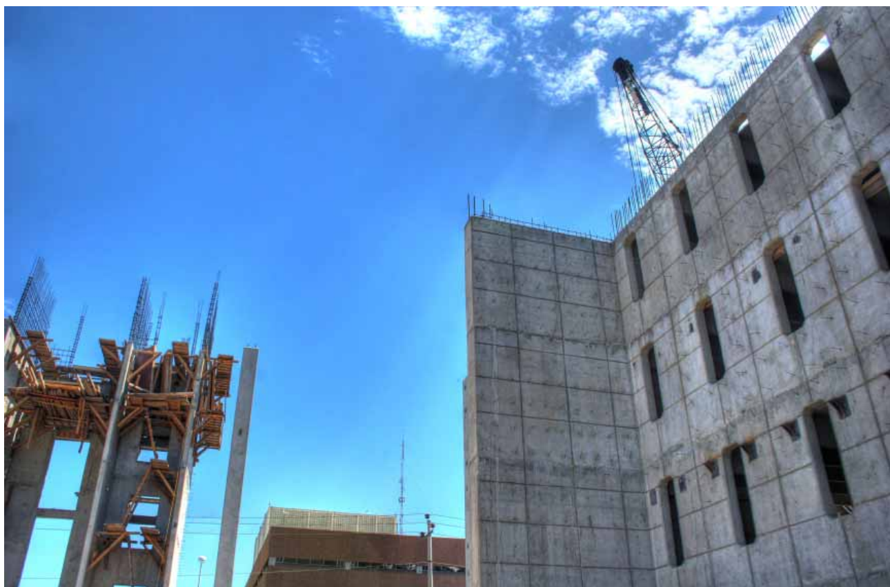
Estacionamiento de cinco niveles en el Centro de Gobierno en Mexicali.
