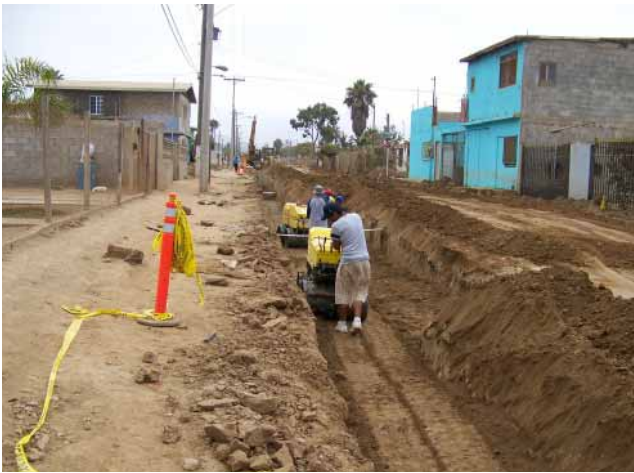
Instalación del emisor a presión, Ex-ejido Chapultepec, Ensenada.
