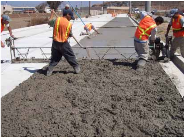
Construcción del Blvd. Zertuche en Ensenada.
