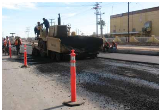
Construcción de la vialidad y embovedado del Río Nuevo en el tramo de la Clzd. Castellón al Blvd. Héctor Terán Terán, Mexicali.
