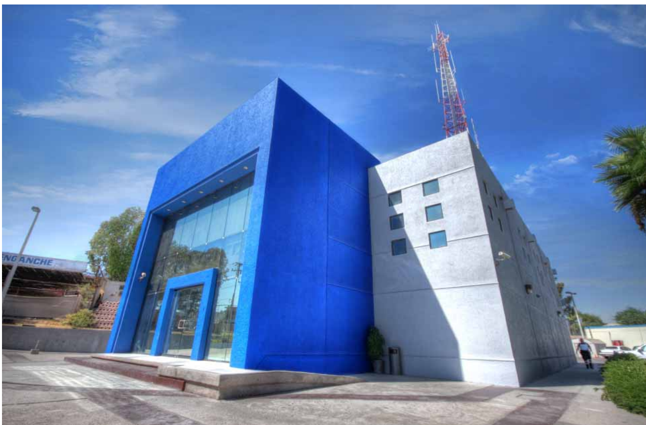
Ampliación de la sala operativa del Centro de Comunicación, Control y Cómputo (C-4), Mexicali.
