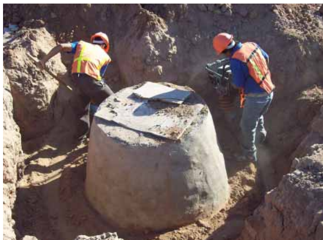
Red de alcantarillado sanitario, Fraccionamiento Bugambilias, Mexicali.
