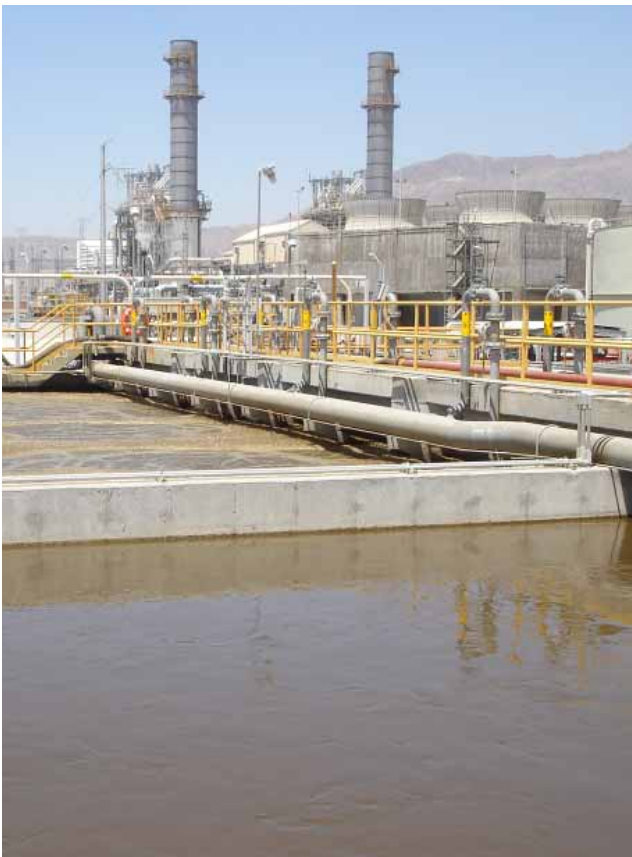
Aguas residuales tratadas para el aprovechamiento en el proceso de generación de energía eléctrica, Mexicali.
