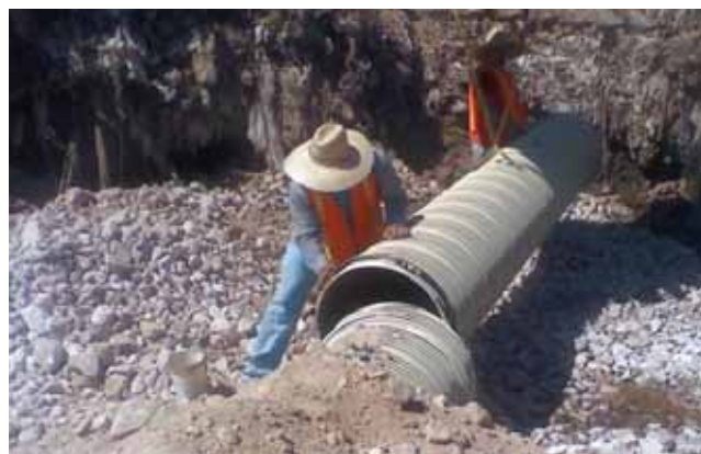
Instalación del drenaje pluvial, Mexicali.
