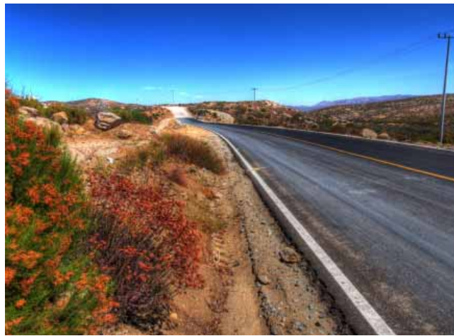
Carretera El Hongo-Ojos Negros, Tecate.
