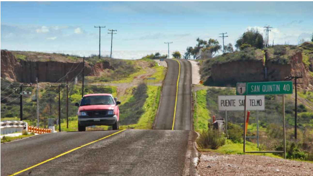
Modernización de la Carretera San Quintín-Lázaro Cárdenas, Ensenada.
