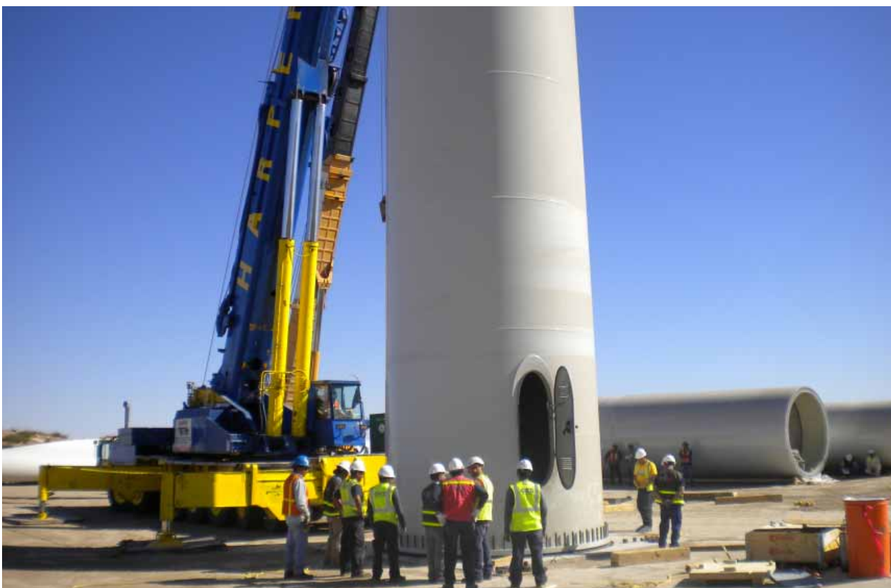
Instalación de la primera torre aerogeneradora en el Parque Eólico La Rumorosa 1, Tecate.
