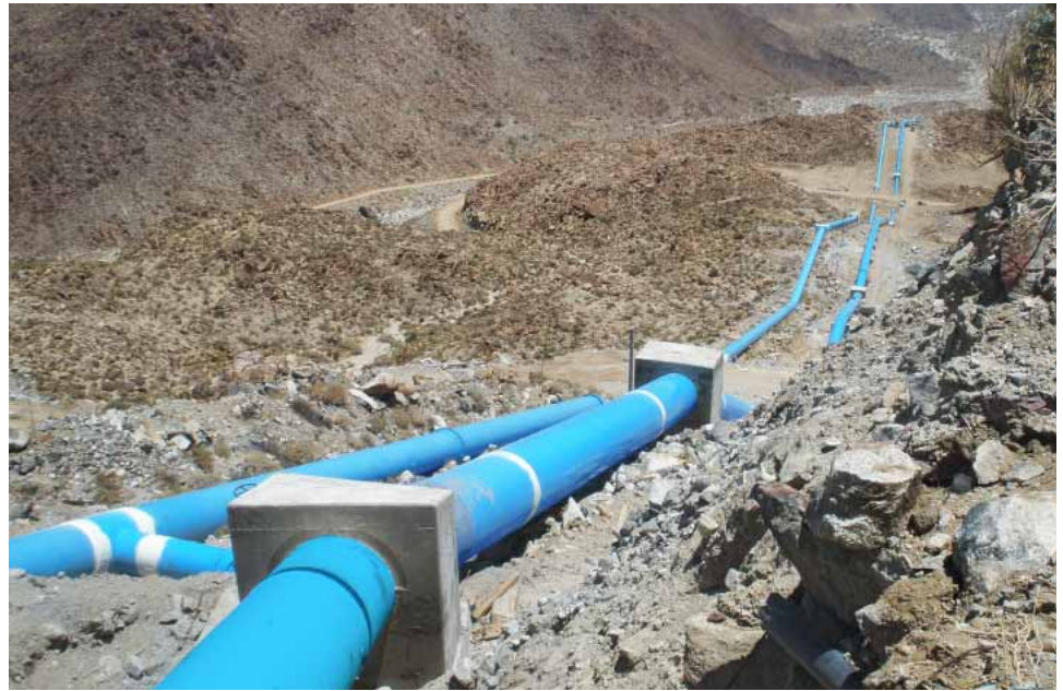
Ampliación del Acueducto Río Colorado-Tijuana
