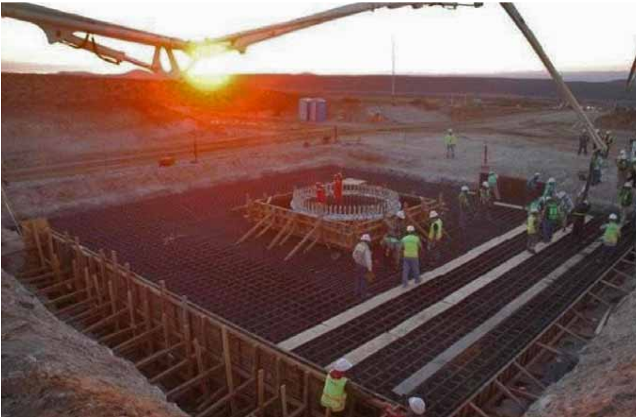
Cimentación de un aerogenerador en Parque Eólico La Rumorosa 1, Tecate.
