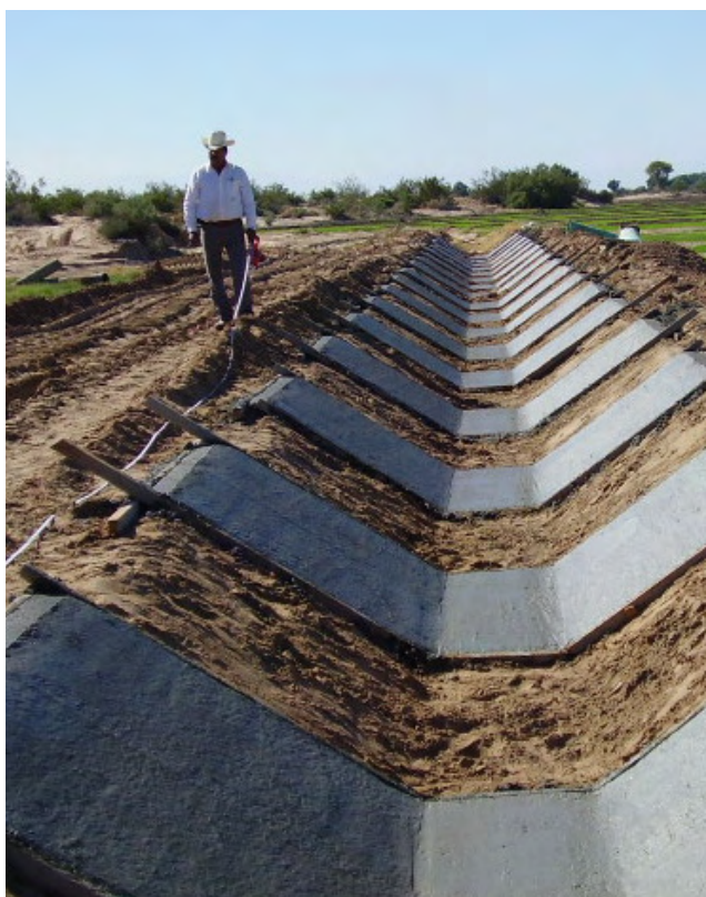
Infraestructura hidroagrícola en el Valle de Mexicali.
