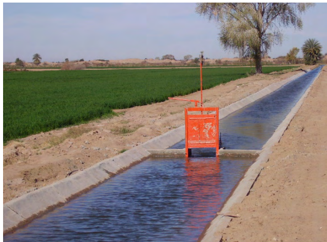
Construcción de canales para riego, Mexicali.
