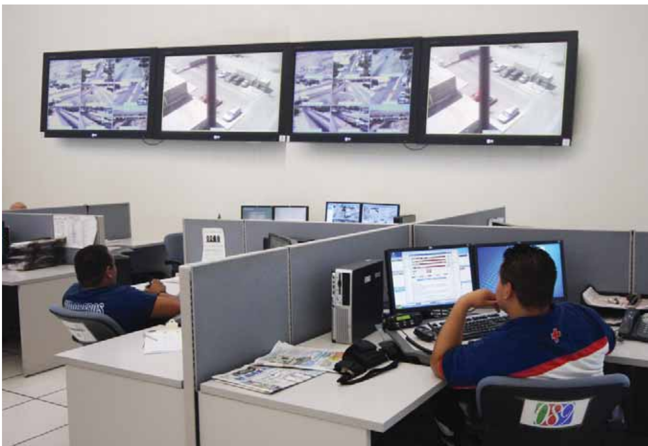
Sala operativa del Centro de Control, Comando, Comunicación y Computo C4, Tecate.
