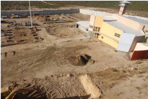
Construcción del CERESO de Media Alta Peligrosidad de El Hongo, Tecate.
