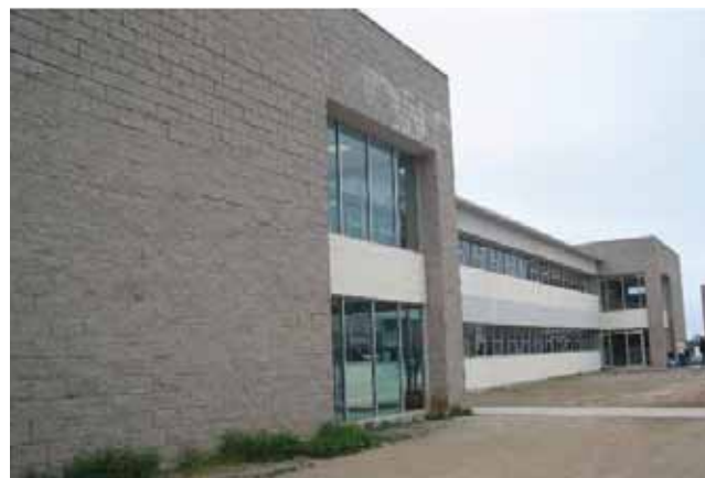
Edificio de Subprocuraduría de la PGJE, Ensenada.
