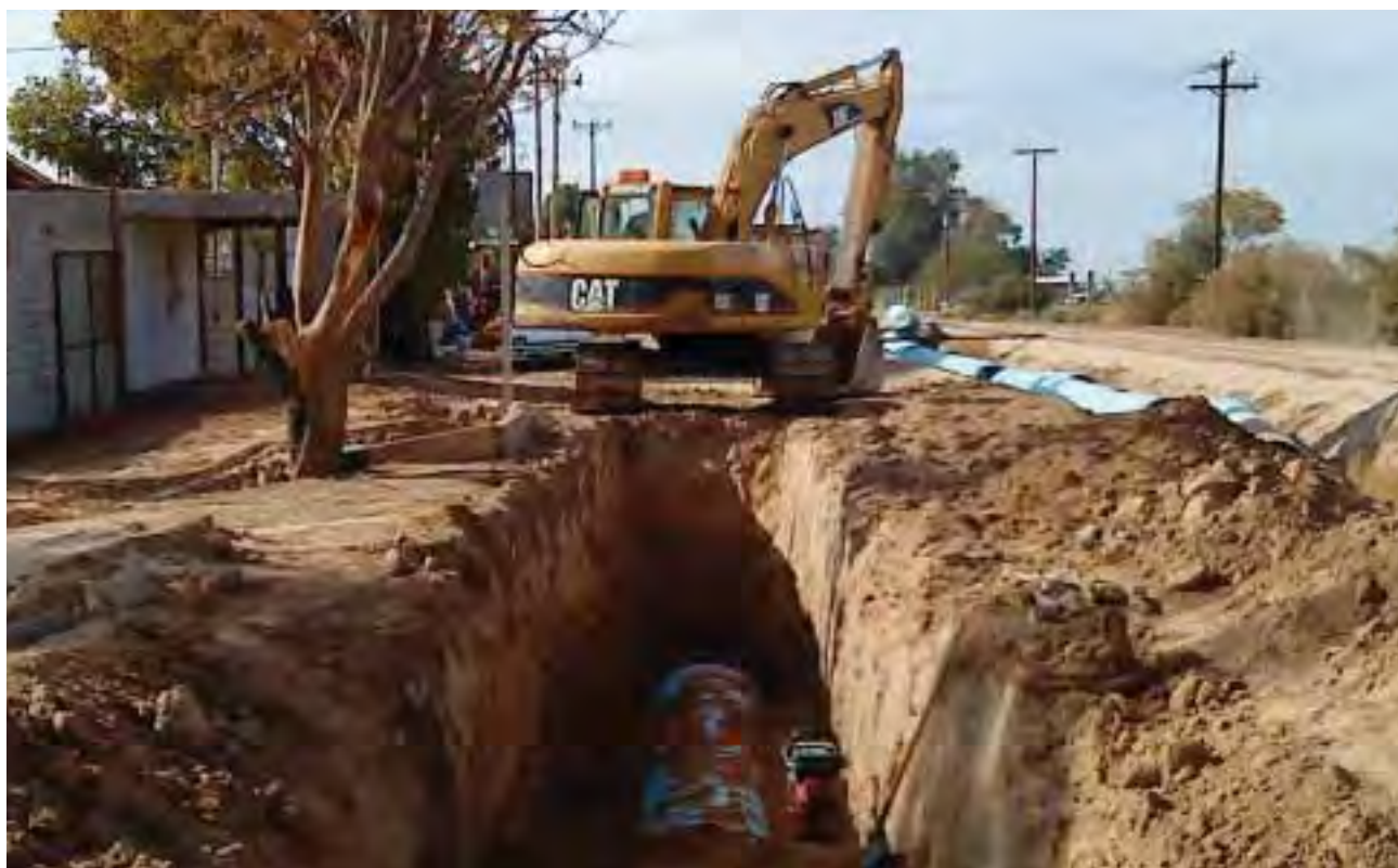
Construcción de la red de aguas residuales, colonia Abasolo, Mexicali.
