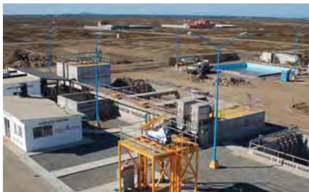
Construcción de la PTAR de Maneadero, Ensenada.
