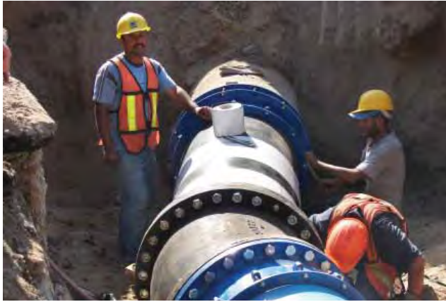
Instalación de la red de agua potable, Tijuana.
