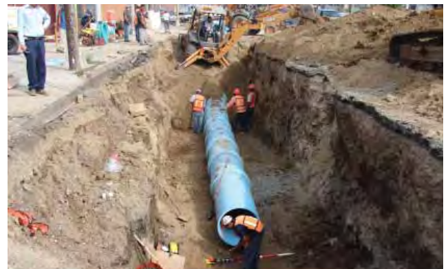
Instalación de la red de agua potable, Tijuana.
