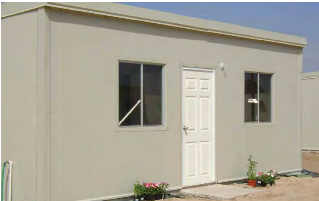
Construcción de viviendas en el Ejido Oaxaca, Valle de Mexicali.
