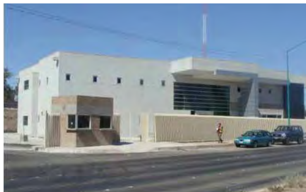
Centro de Control y Confianza C3, Mexicali.
