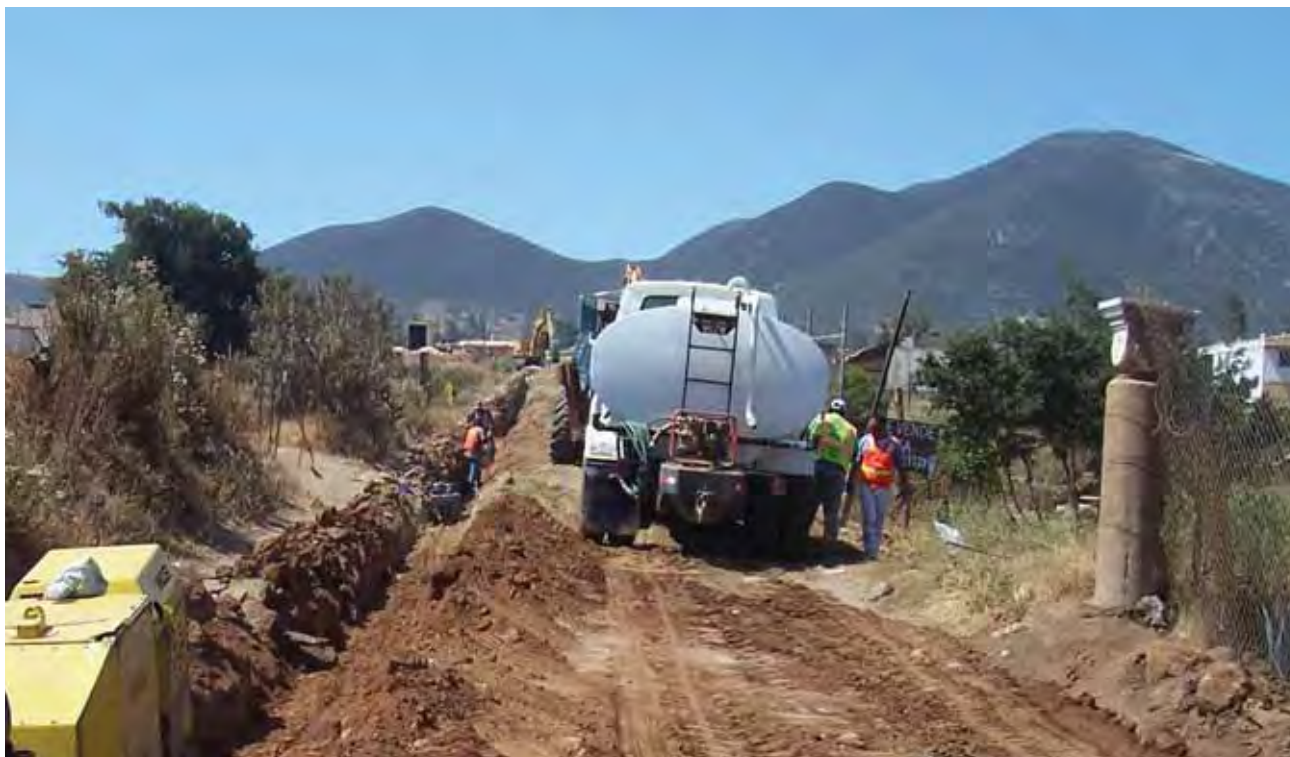
Construcción de la red de agua potable, colonia Hindú, Tecate.
