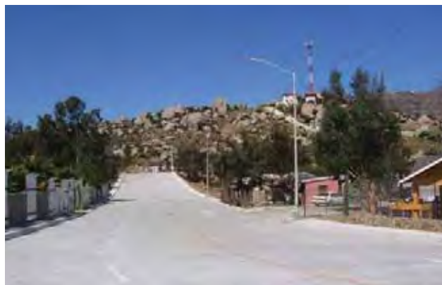
Construcción de la prolongación del Bulevar Encinos, Tecate.
