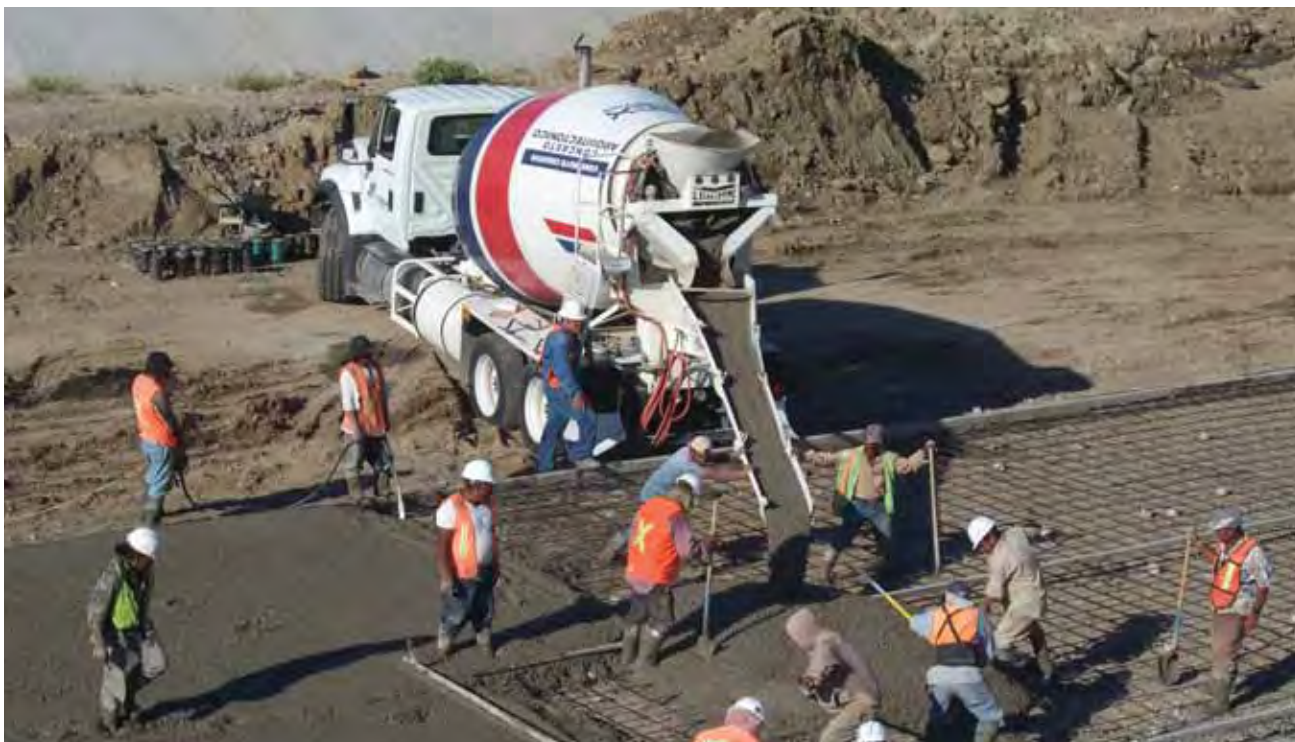
Colado de concreto en plantilla de revestimiento del Arroyo Alamar, Tijuana.
