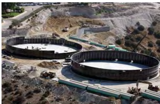
Construcción de dos tanques de almacenamiento de agua, Tijuana.
