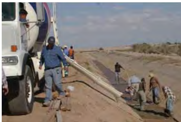
Reconstrucción de canales para riego, Valle de Mexicali.
