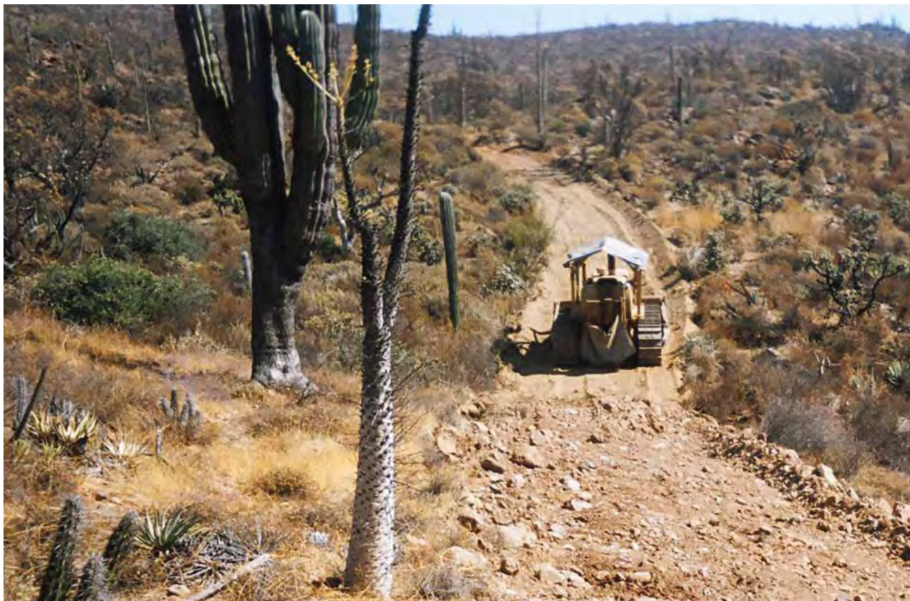
Mantenimiento del camino de acceso al sur del Rosario, Ensenada.
