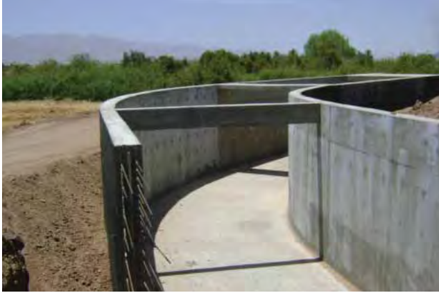
Construcción de infraestructura para agua de riego, Valle de Mexicali.
