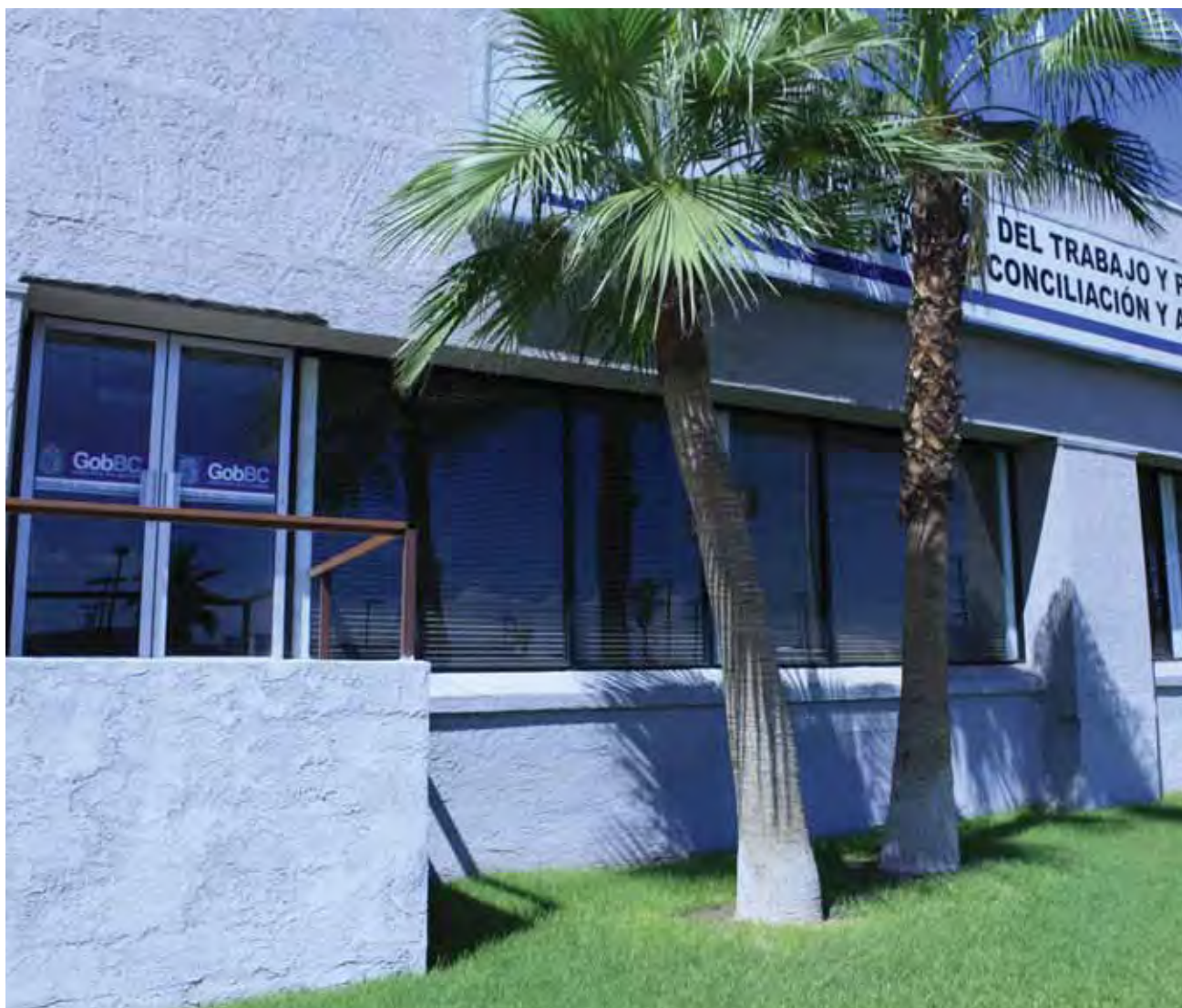
Nuevas instalaciones de las oficinas de la Secretaría del Trabajo y Previsión Social, Mexicali.
