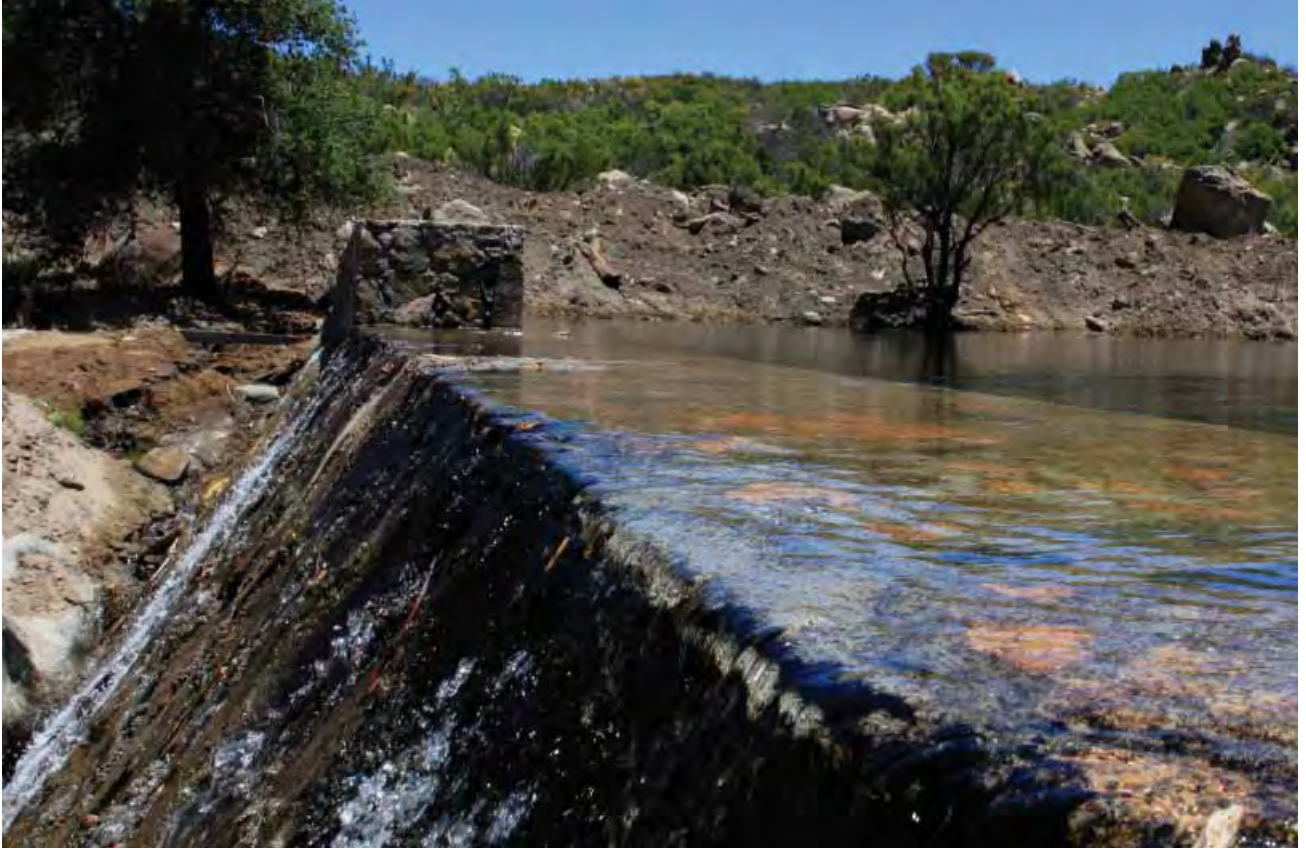
Obras de captación de agua, Tecate.
