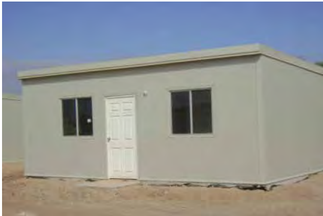
Programa de apoyo para viviendas afectadas por el sismo, Valle de Mexicali.
