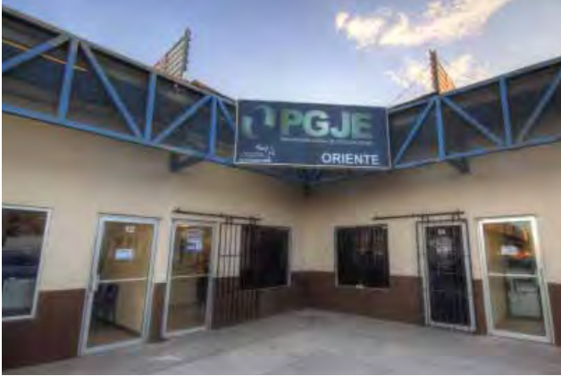
Acondicionamiento de la Agencia del Ministerio Público, Mexicali.
