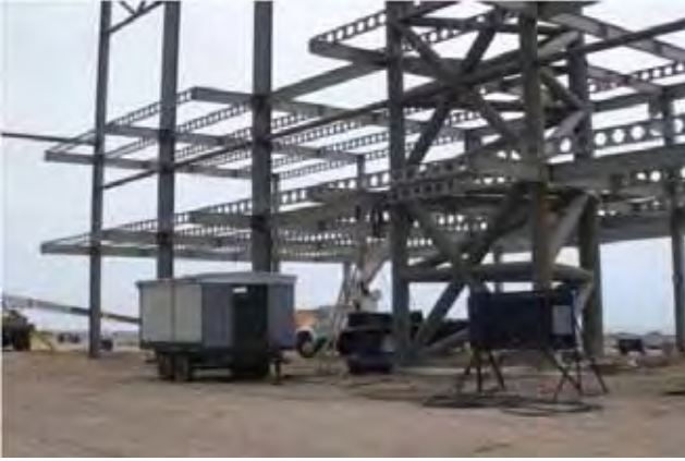
Centro de Convenciones Metropolitano en construcción, Playas de Rosarito.
