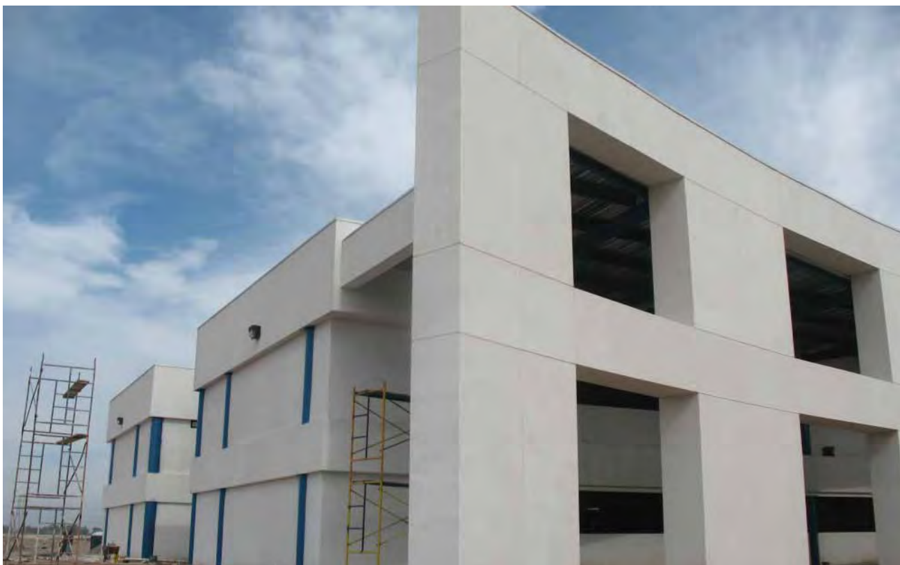
Construcción del edificio de la UPBC, Mexicali.
