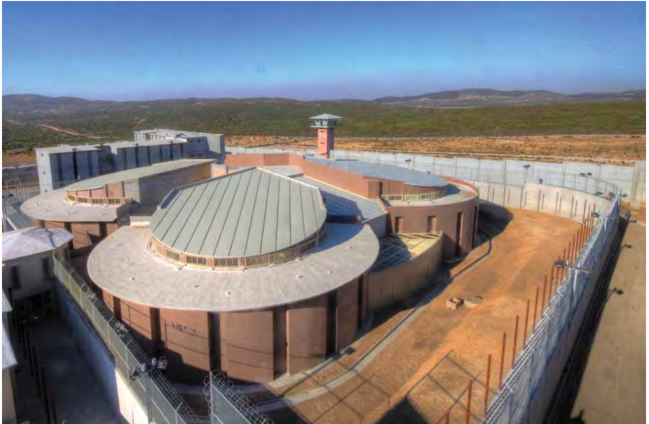
Construcción del nuevo CERESO, El Hongo III.
