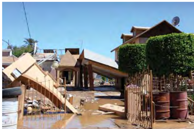
Evaluación de daños por el sismo 7.2, Valle de Mexicali.
