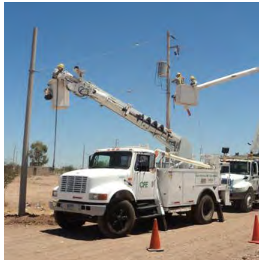
Trabajo de electrificación, Ensenada.
