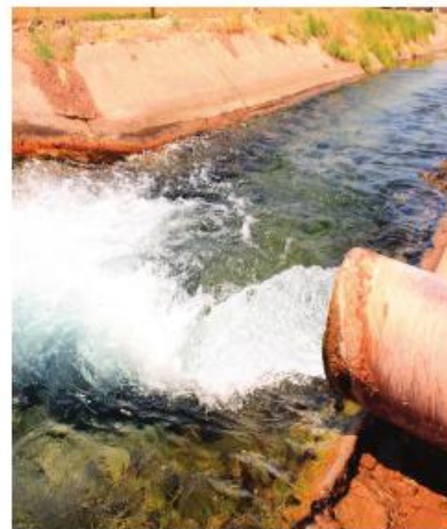
Pozo Hidroagrícola en el Valle de Mexicali.
