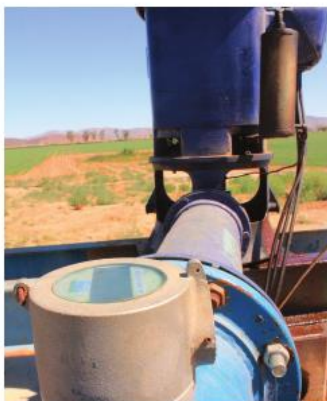
Instalación de medidores volumétricos Ojos Negros.
