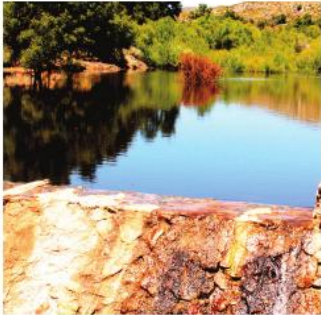
Construcción del represo en el ejido Laguna Hanson.
