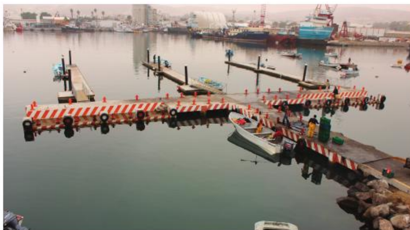
Infraestructura en Muelle de El Sauzal, Ensenada B.C.
