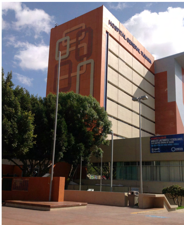
Remodelación Hospital General de Tijuana.
