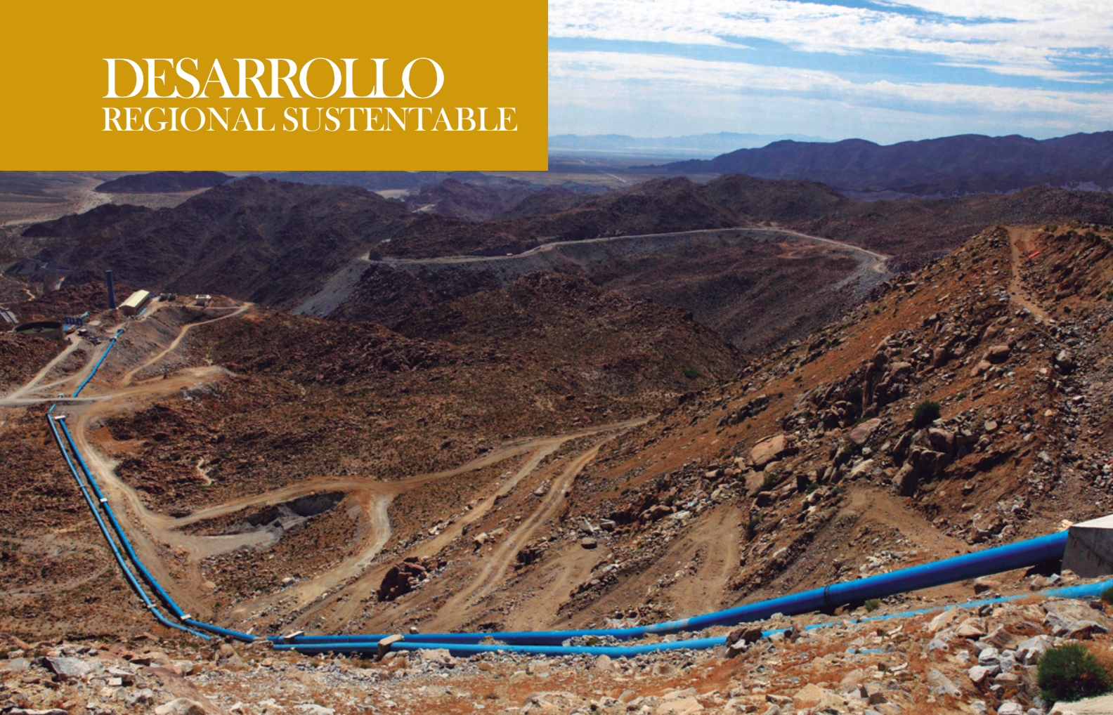
Acueducto Río Colorado Tijuana.
