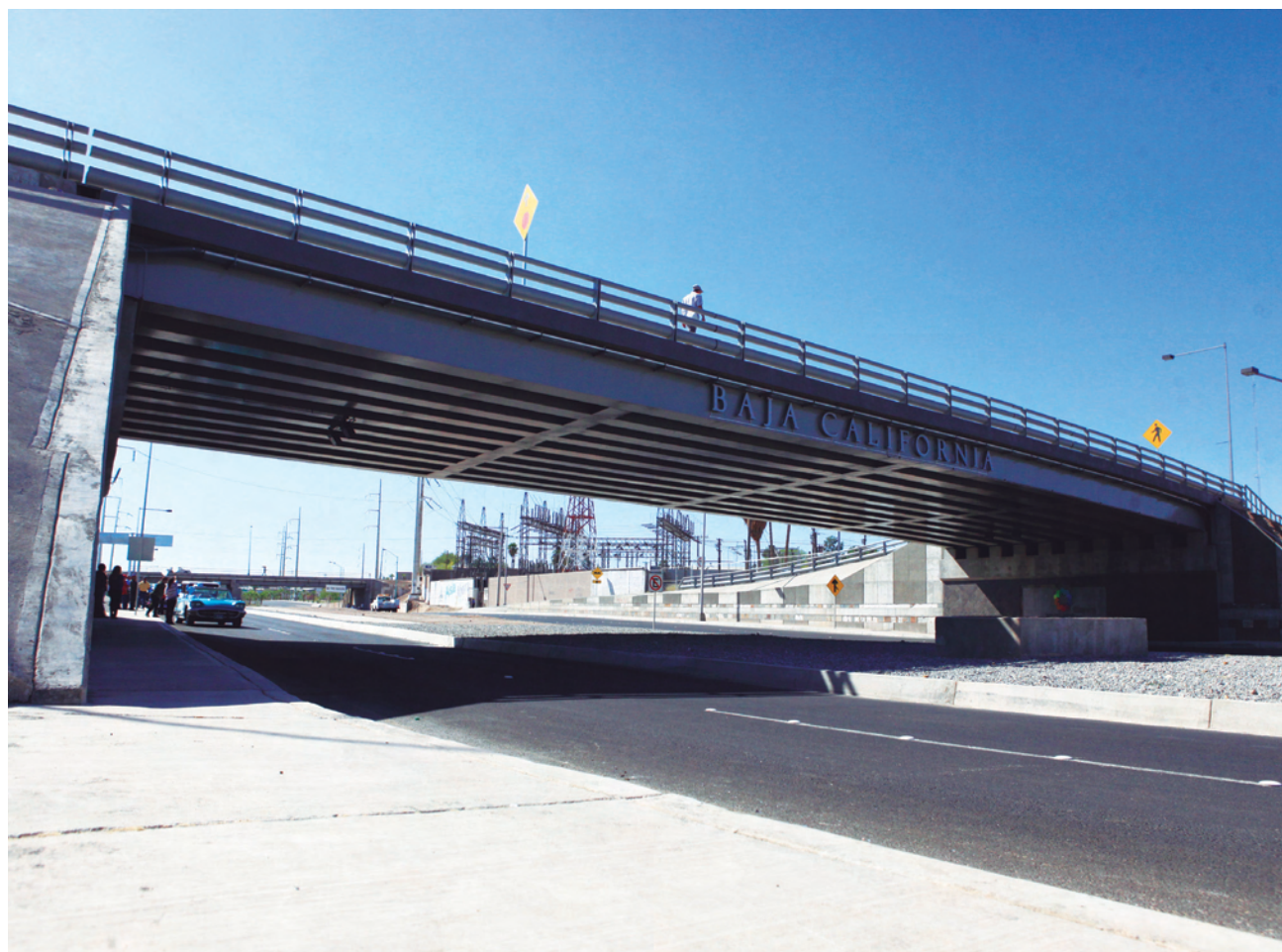
Puente Reforma, Mexicali, B.C.
