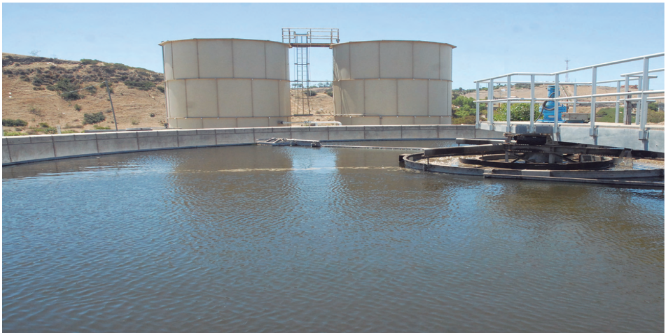
Ampliación Planta de Tratamiento de Aguas Residuales Rosarito I.
