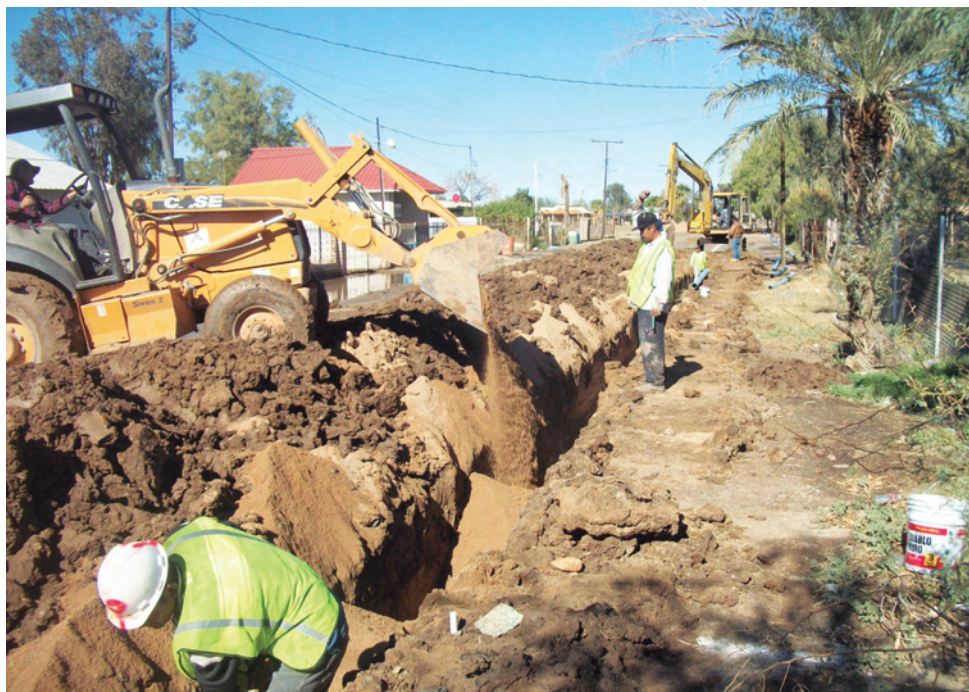
Introducción de la red de agua potable, Ejido Hidalgo, Mexicali, B.C.
