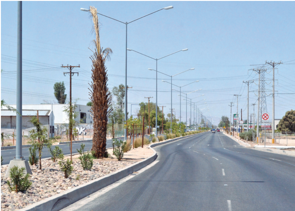
Construcción de la Calzada Independencia, Mexicali, B.C.
