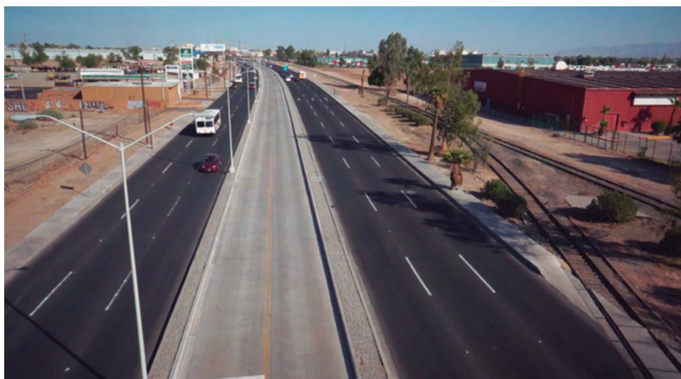
Reconstrucción del Corredor Palaco, Mexical, B.C.
