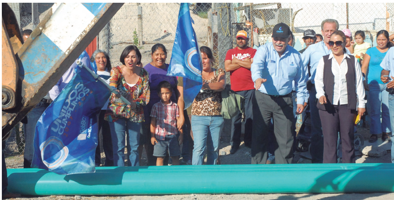
Arranque de la obra de la red de alcantarillado sanitario en la Colonia Lucio Blanco en Playas de Rosarito, B.C.
