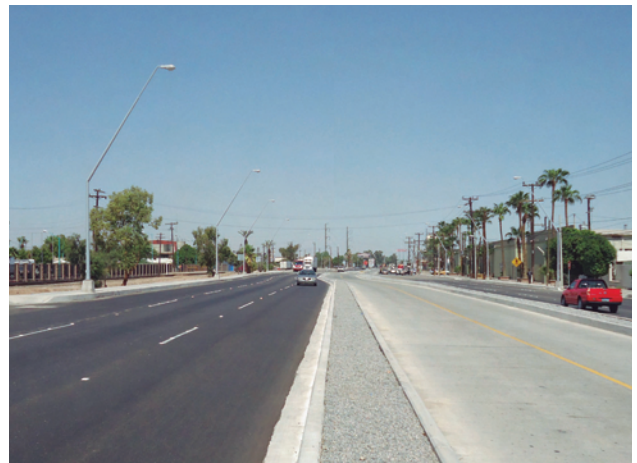
Ampliación y modernización del Corredor Industrial Palaco.
