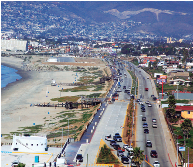
Construcción de la prolongación del Bulevar Costero.
