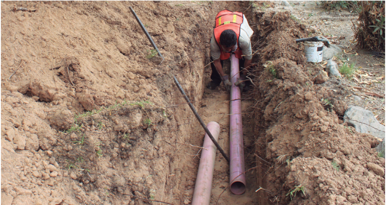
Instalación de tubería morada en Mexicali, B.C.
