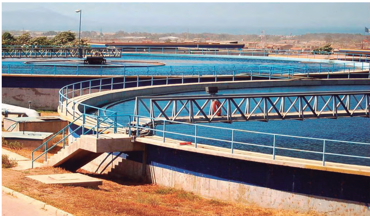
Planta de Tratamiento de Aguas Residuales El Naranjo, Ensenada, B.C..
