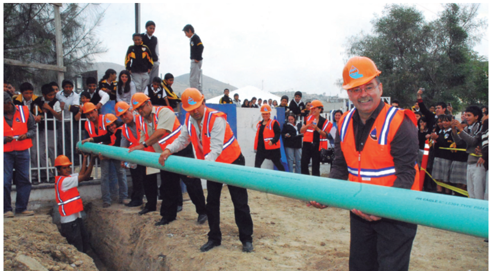
Instalación de la red de alcantarillado sanitario en Vistas del Valle, Tijuana, B.C.
