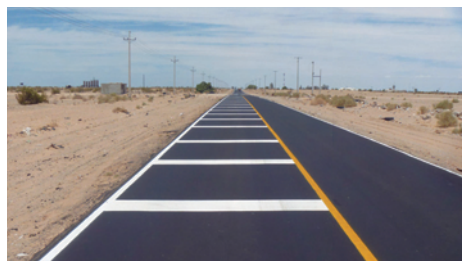
Trabajo de sobrecarpeta en las carreteras del Valle de Mexicali, B.C.
