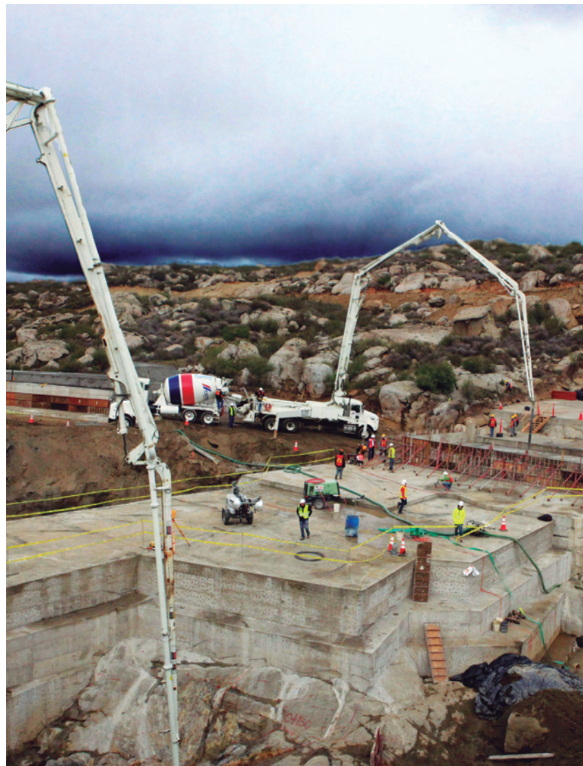
Trabajos en la cortina de la Presa Las Auras en Tecate.
