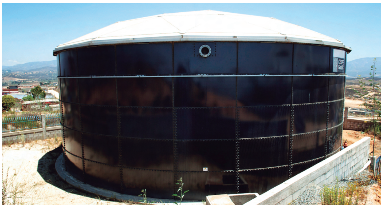
Construcción de Tanque de Vidrio Fusionado al Acero, Ensenada, B.C.
