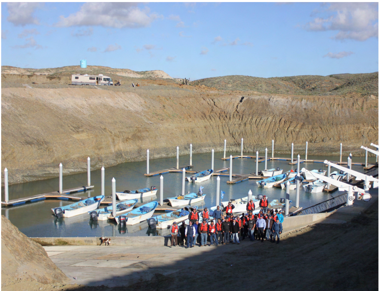
Vista al atracadero, Punta San Antonio El Rosario, B.C.
