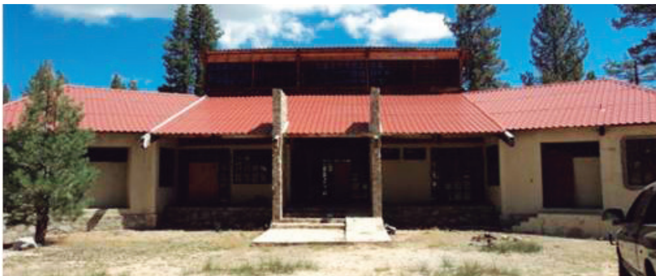
Construcción de kiosco de servicios en el Parque Nacional Sierra San Pedro Martir.
