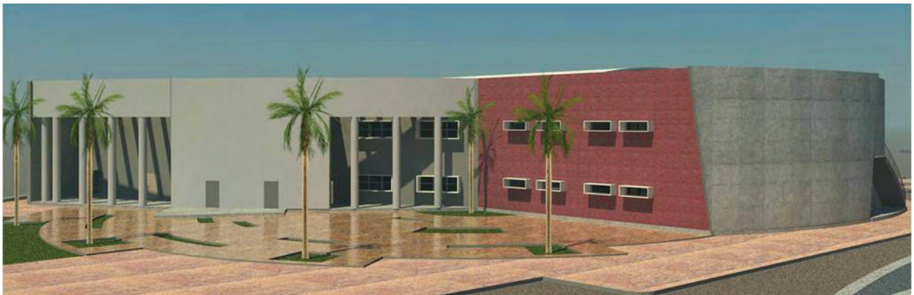
Nuevo Centro de Control, Comando, Comunicación y Computo C4 Tijuana.
